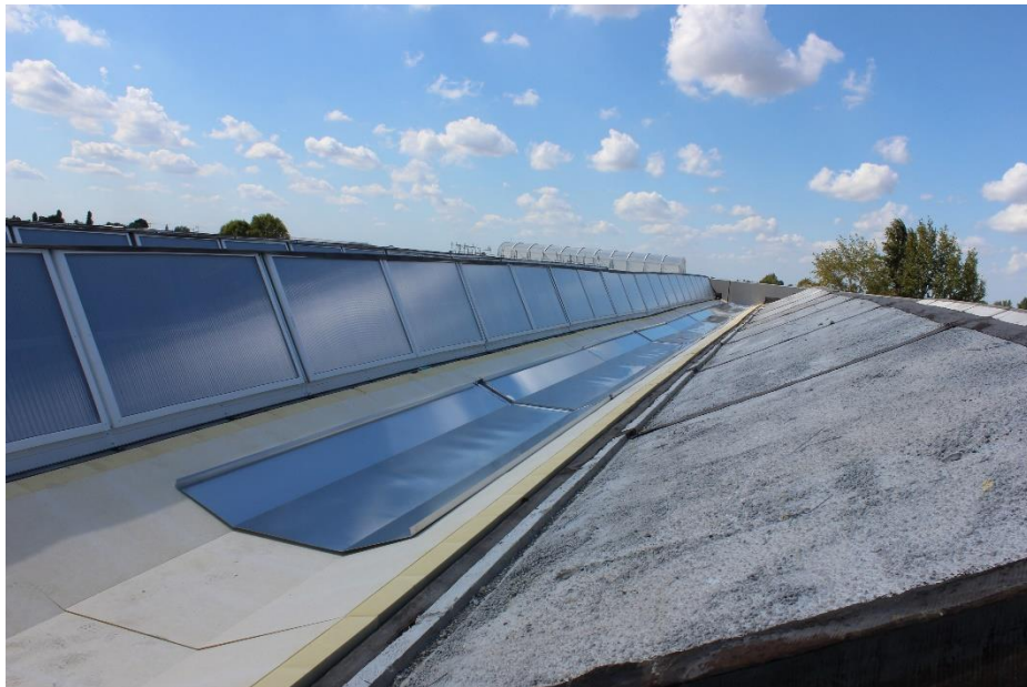
Fasi di realizzazione dell'isolamento termico di una copertura industriale con POLIISO su misura
